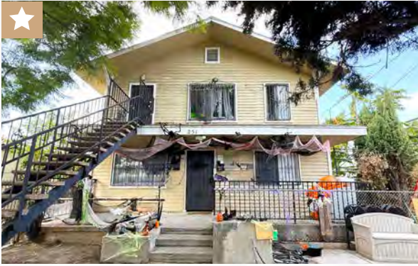
251 N BURLINGTON AVE LOS ANGELES, CA 90026
