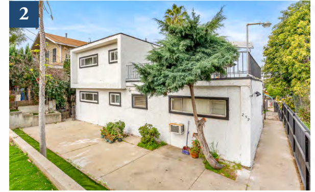
259 N BURLINGTON AVE LOS ANGELES, CA 90026
